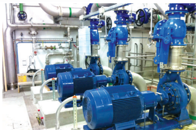
Рисунок 14 — Практический пример: насосная станция с 3-мя обратными клапанами DN200, использующими классическое решение демпфирования, в добавок к проблемам с интенсивными ударами, теряет ежегодно: 3 \times 4,000 \text{ €/год} = 12,000 \text{ €/год}
