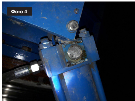
Фото 7-8. Смонтированные обратные затворы DN 2200 с демпфирующими системами
