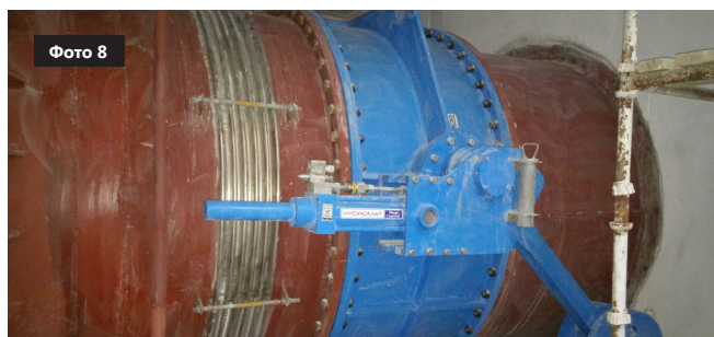
Фото 7-8. Смонтированные обратные затворы DN 2200 с демпфирующими системами
