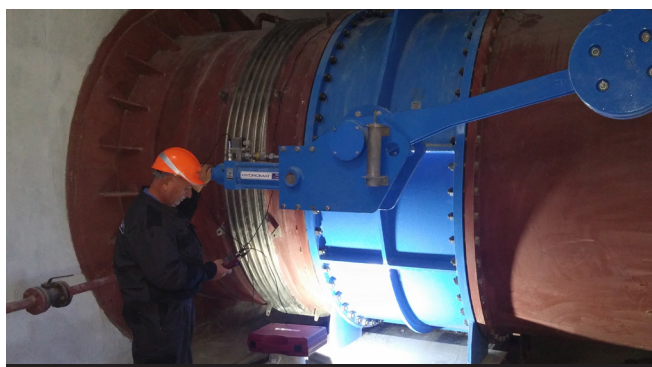
Фото 12. Инженер по шефмонтажу HYDROMAT регистрирует характеристику демпфирования и настраивает демпфирующие системы в рабочих условиях эксплуатации
