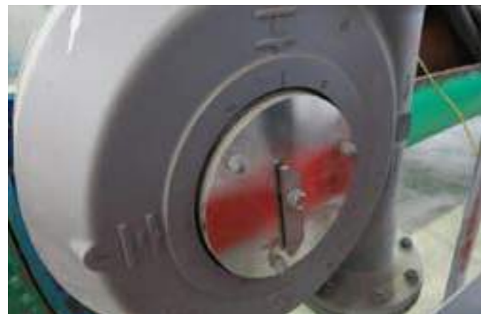
Рисунок 5 Неправильный мультифункциональный комбинированный клапан и результат его некорректной работы
