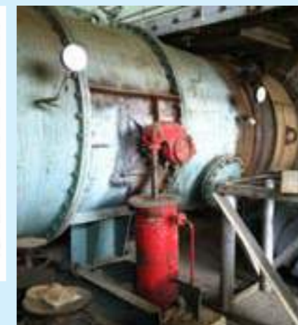
Рисунок 7 – Нет-нет, вы не ошиблись, обратные клапаны по типу «бабочка» с двустворчатым диском Ду 2200 действительно есть в природе. По причине редкости таких изделий больших диаметров предлагается сразу занести их в арматурную Красную книгу. Масса изделия – около 2 тонн
