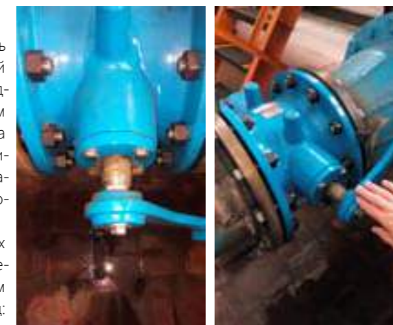
Рисунок 10 Обратные клапаны V2-09: два клапана слева – с разрезным валом, два клапана на правом фото имеют цельный вал
