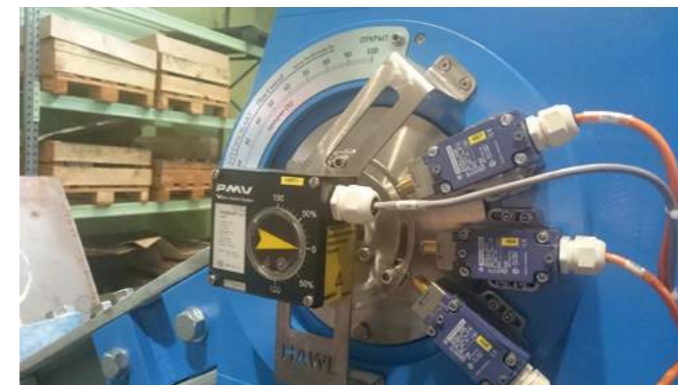
Рисунок 15 — Механический указатель, позиционер и БКВ
