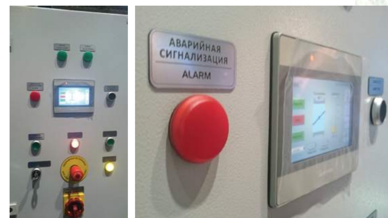
Рисунок 8,9 — Шкаф управления HAWL с сенсорным экраном
