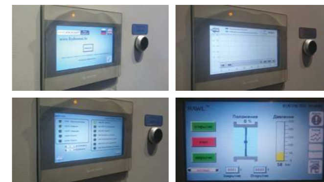
Рисунок 16, 17, 18, 19 — Концепция user friendly в наглядном виде: русифицированный сенсорный экран, различная информация о работе привода-арматуры
